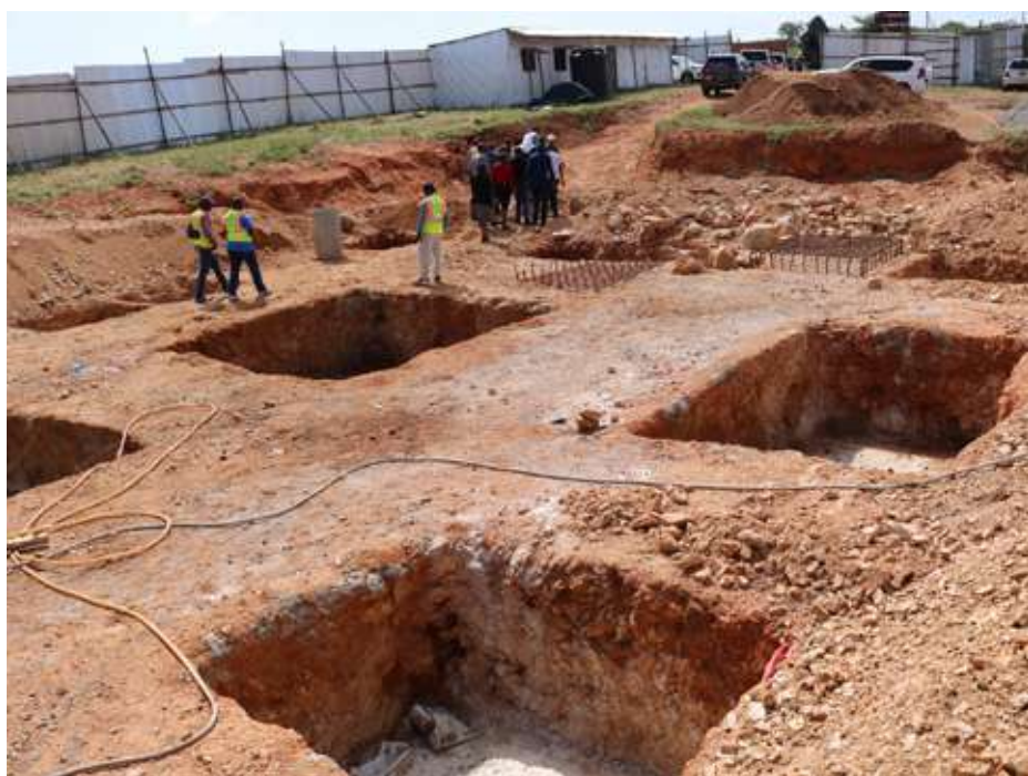
Mwonekano wa hatua iliyofikiwa katika mradi wa ujenzi wa jengo la Ofisi za TSC Makao Makuu unaofanyika katika eneo la Ndejengwa jijini Dodoma.
